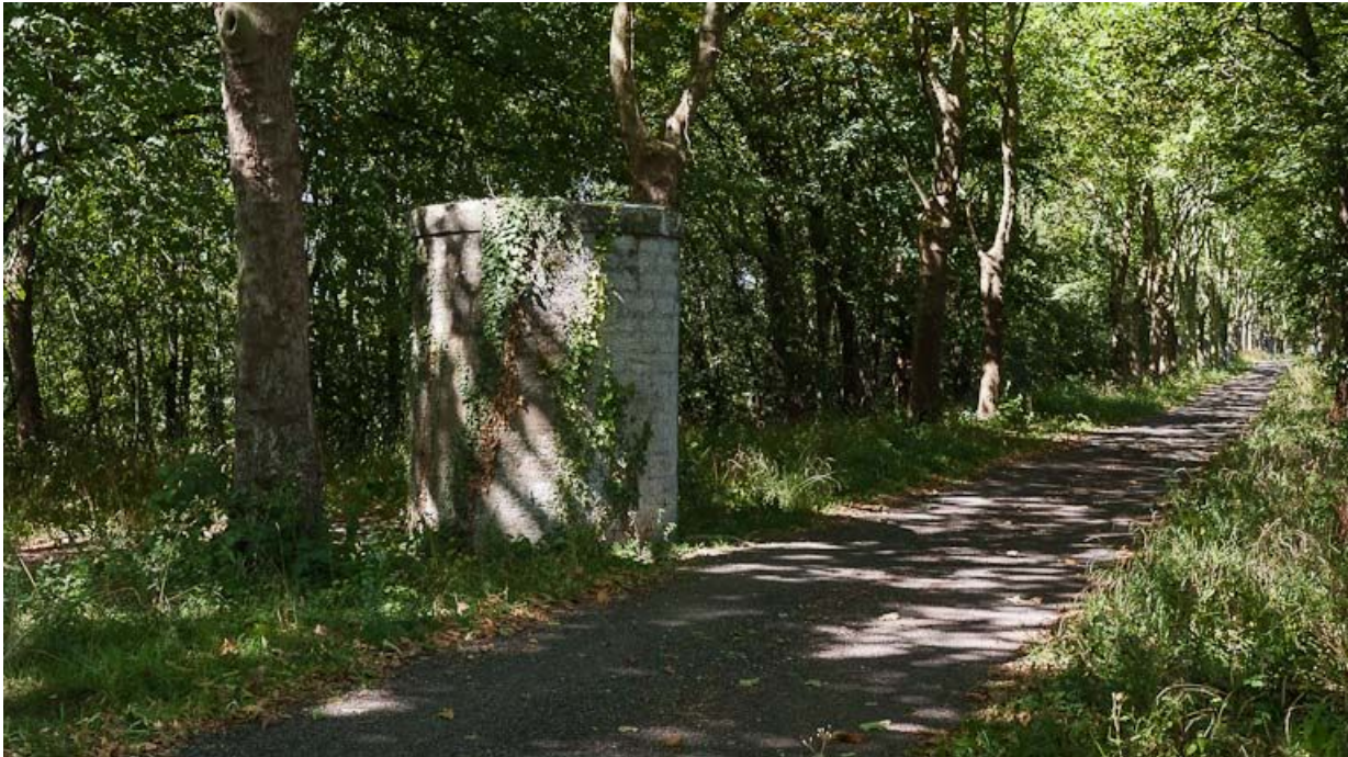
Vue d'un puits d'aération du tunnel.
