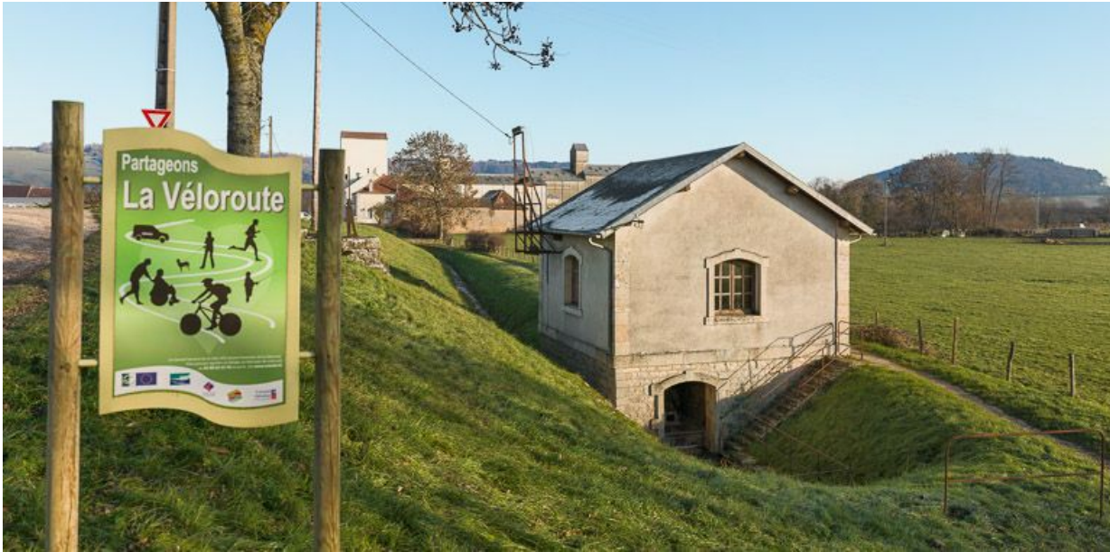
façade postérieure de l'usine.
