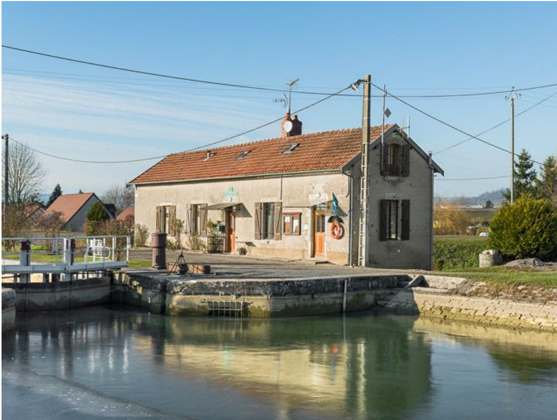
Vue de 3/4 de la maison éclusière.
