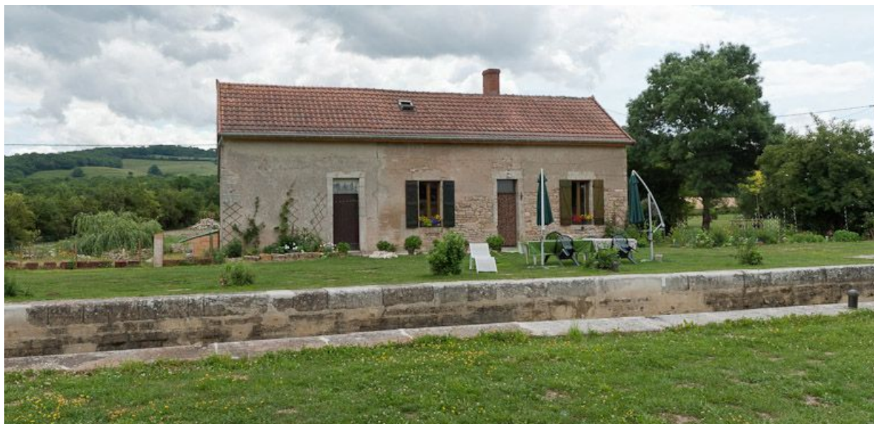
Vue de face de la maison éclusière.
