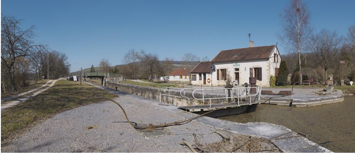
Le site d'écluse vu d'amont.
