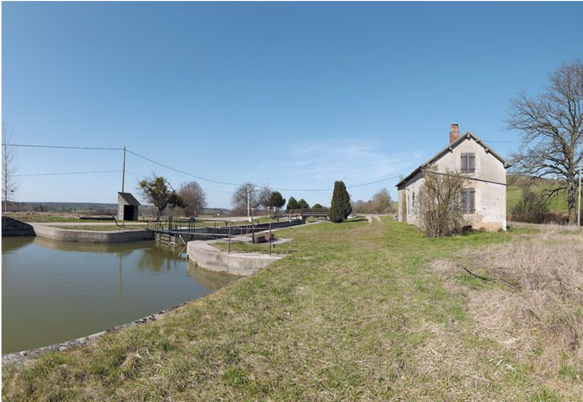
Le site d'écluse vu d'amont.
