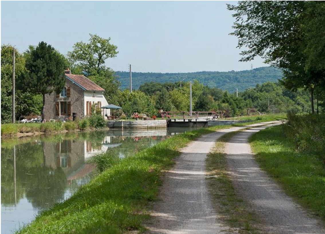
Vue du site d'écluse depuis l'amont.
