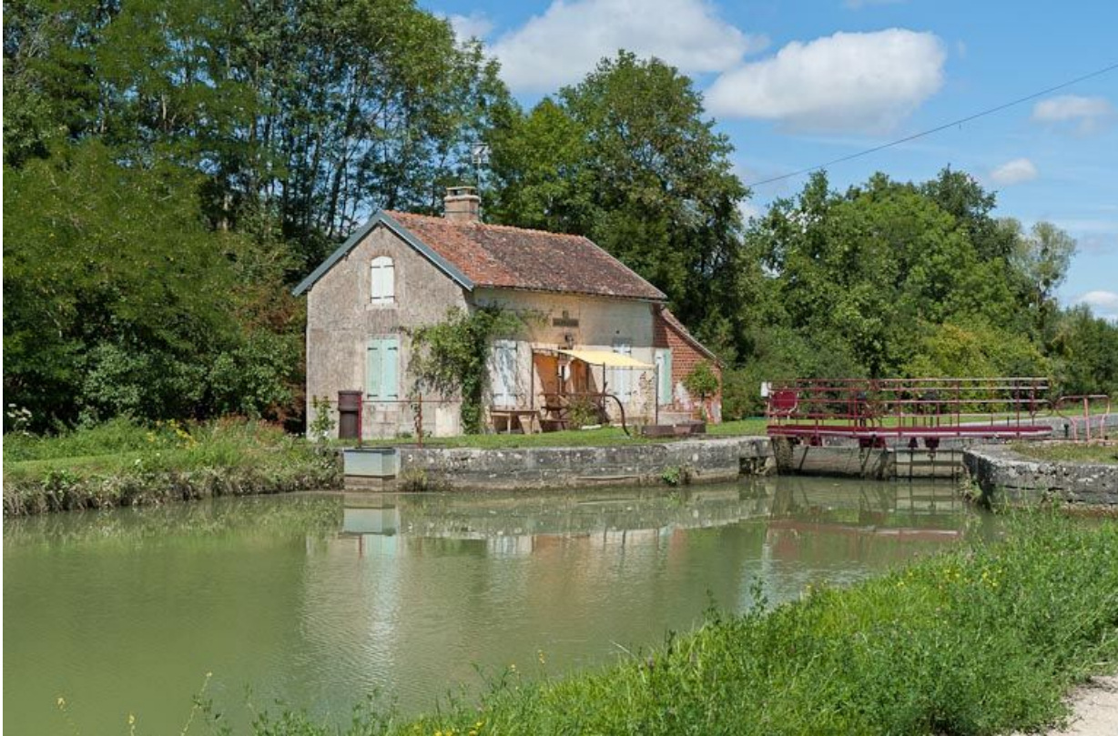
Vue du site d'écluse depuis l'amont.
