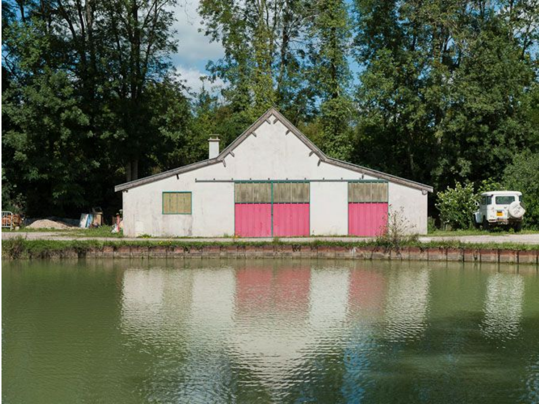
Vue d'un hangar sur le port.
