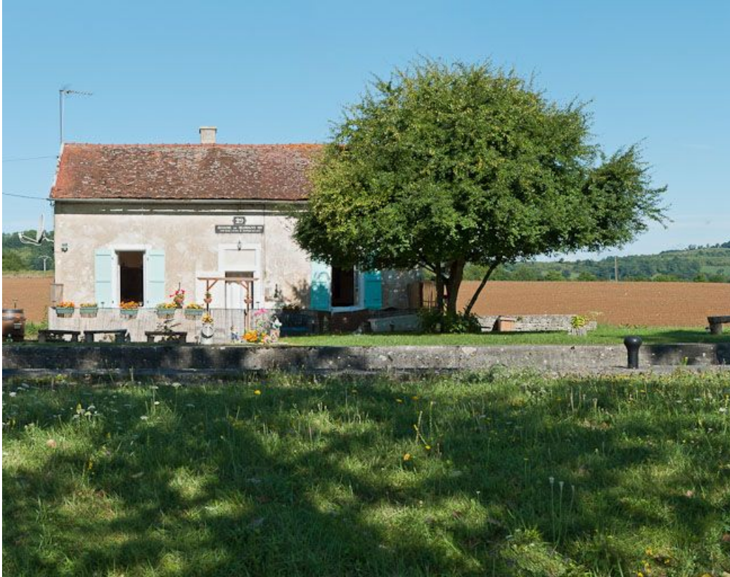
Vue de face de la maison éclusière.
