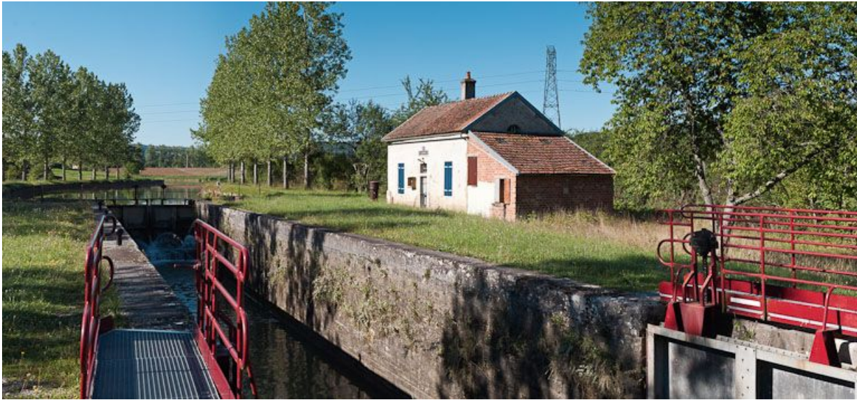
Vue d'ensemble du site d'écluse.
