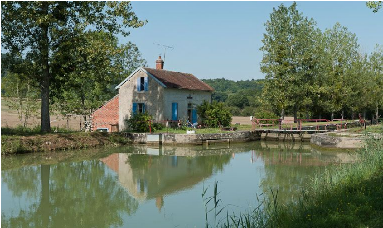
Vue du site d'écluse depuis l'amont.
