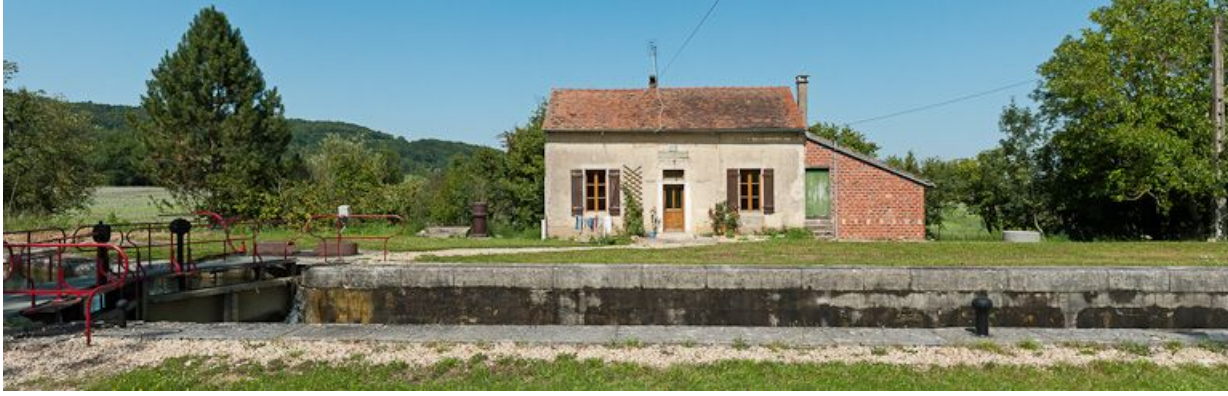
Vue de face de la maison éclusière.
