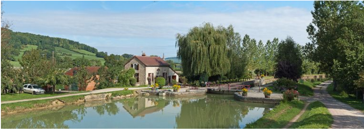
Vue du site d'écluse depuis l'amont.
