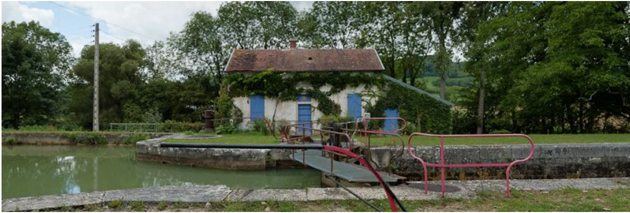
Vue de face de la maison éclusière.
