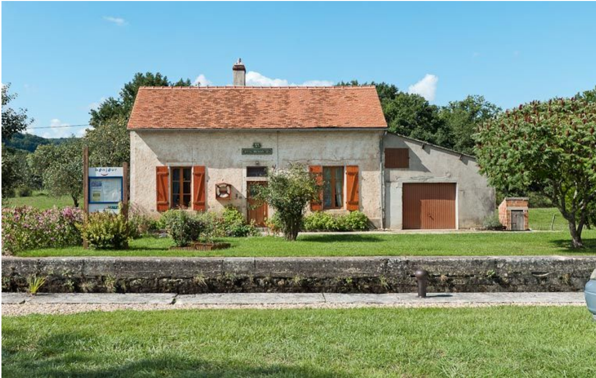
Vue de face de la maison éclusière.
