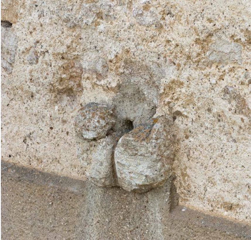
Vue de la pierre d'écoulement d'évier.
