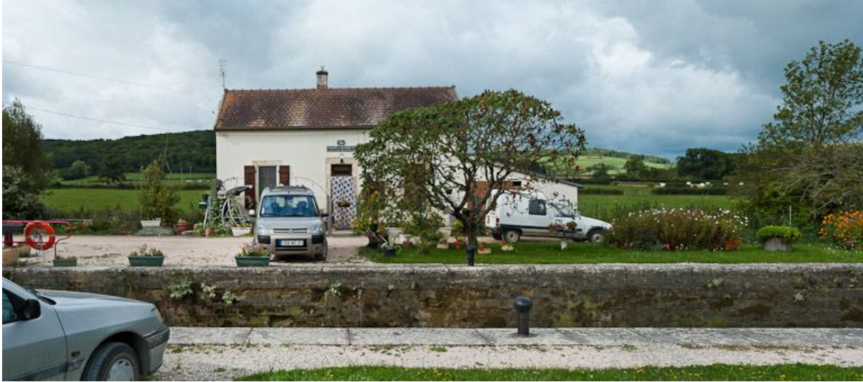
Vue de face de la maison éclusière.
