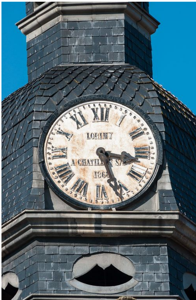
Façade sur rue : détail (cadran de l'horloge).
