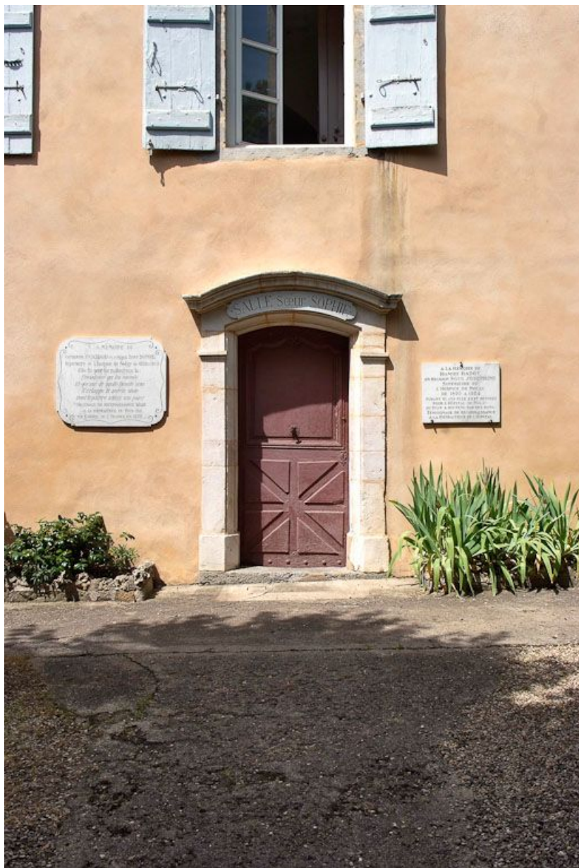
Façade antérieure, détail de la partie centrale.
