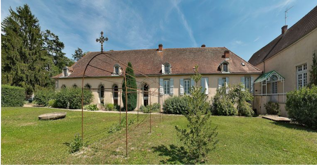
Façade postérieure de l'ancien hôpital.
