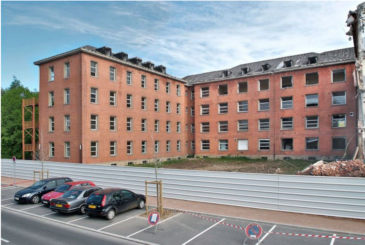
Bâtiment hospitalier en cours de démolition.
