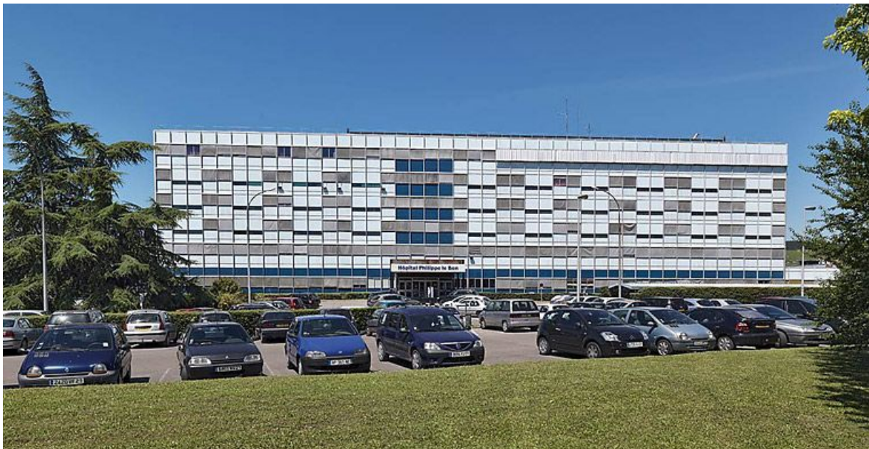
Bâtiment principal, façade.
