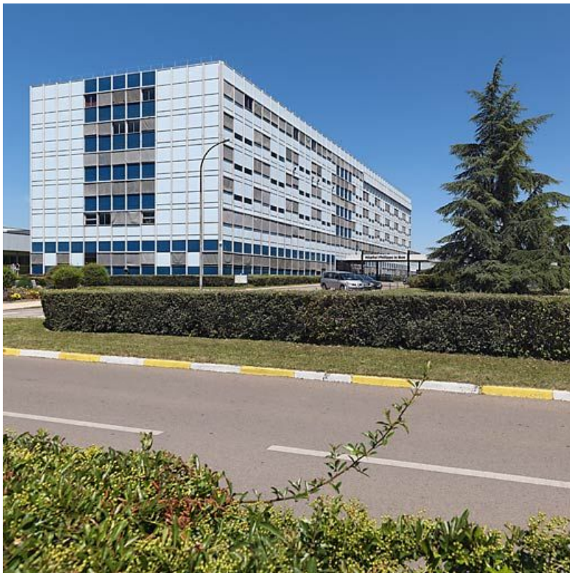
Bâtiment principal, vue d'ensemble de trois-quarts.
