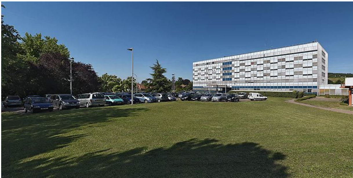
Bâtiment principal, vue d'ensemble.
