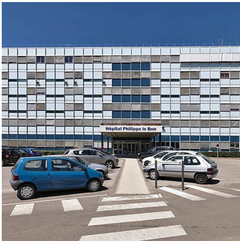
Bâtiment principal, partie centrale de la façade.
