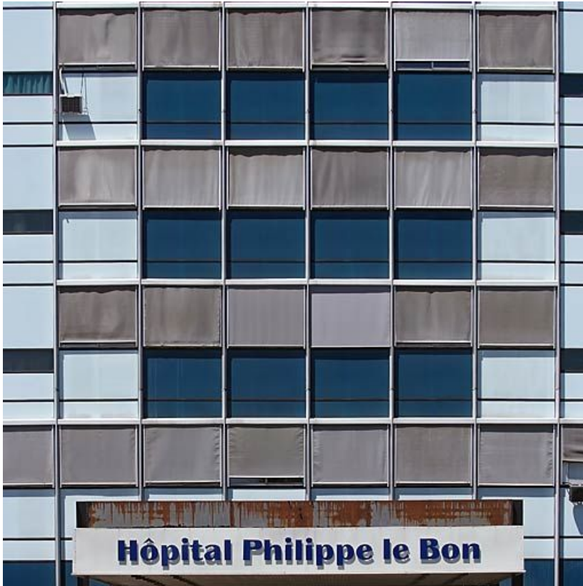
Bâtiment principal, détail de la façade.
