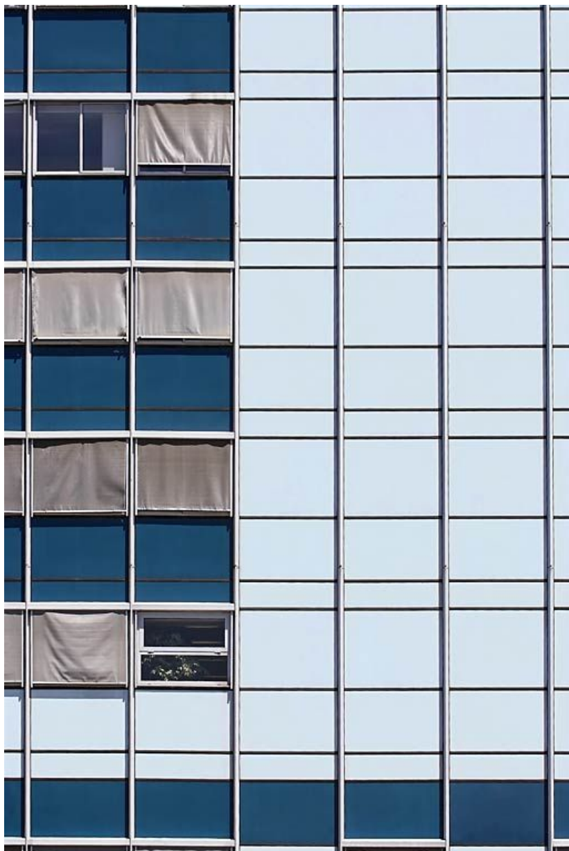
Bâtiment principal, détail.
