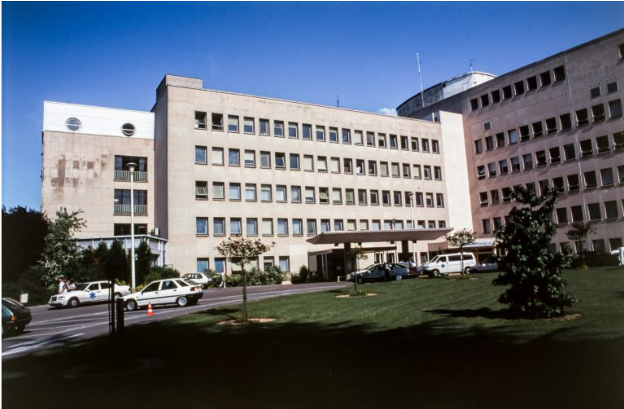
Vue du bâtiment d'entrée.
