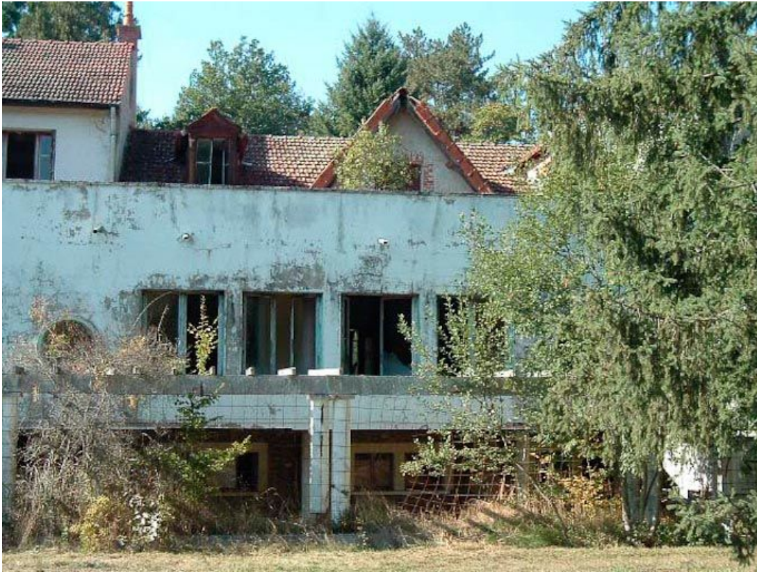
Bâtiment principal, façade antérieure, partie droite.
