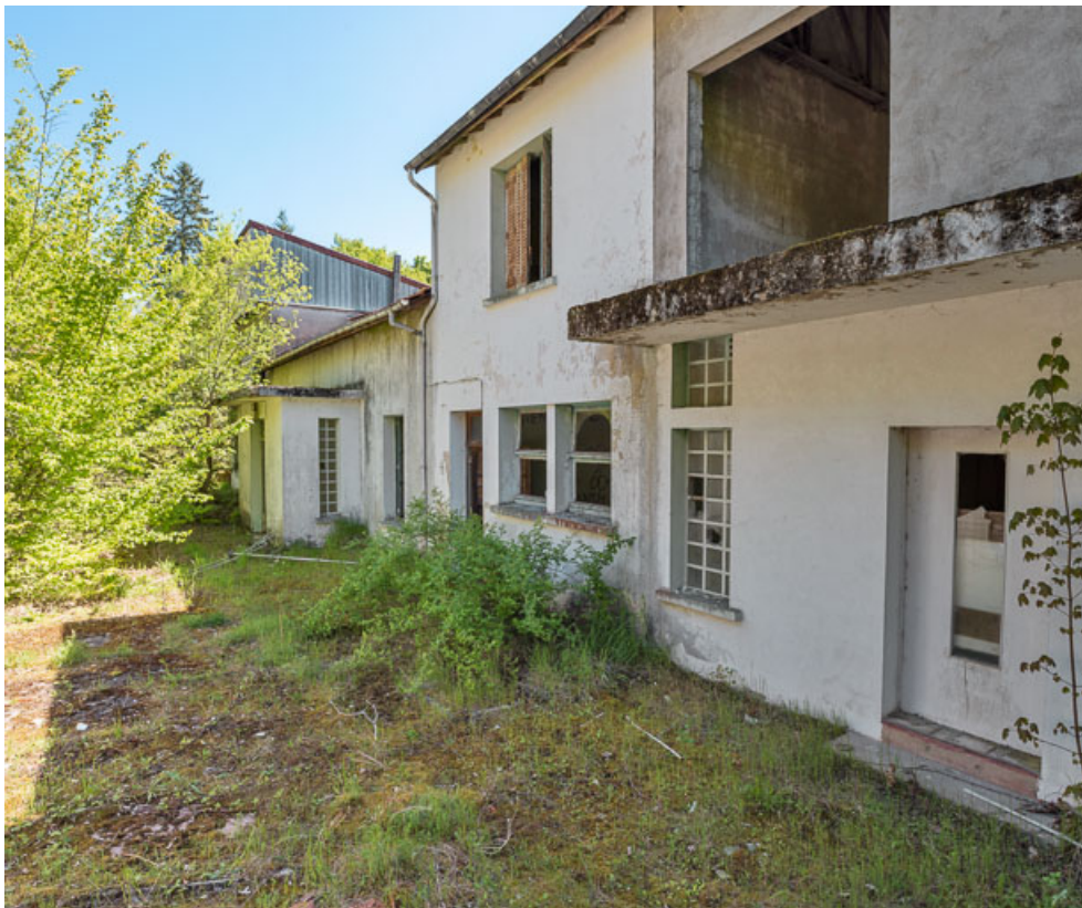
Bâtiment principal, façade postérieure, vue de trois-quarts.
