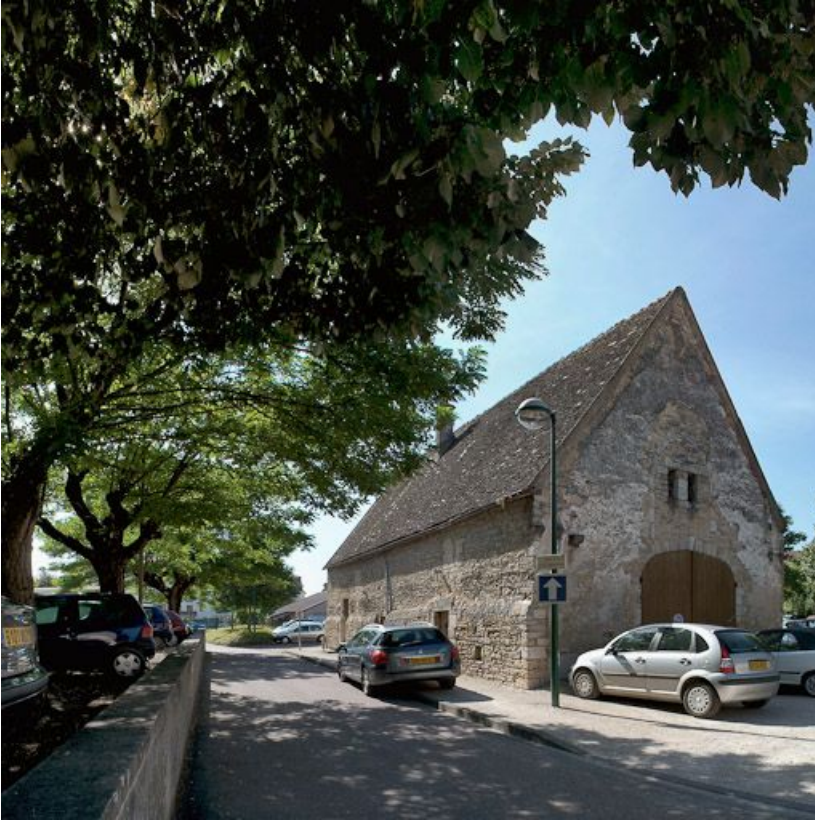
Façade antérieure et élévation gauche. 21, Beaune Moulin-Saint-Jacques
