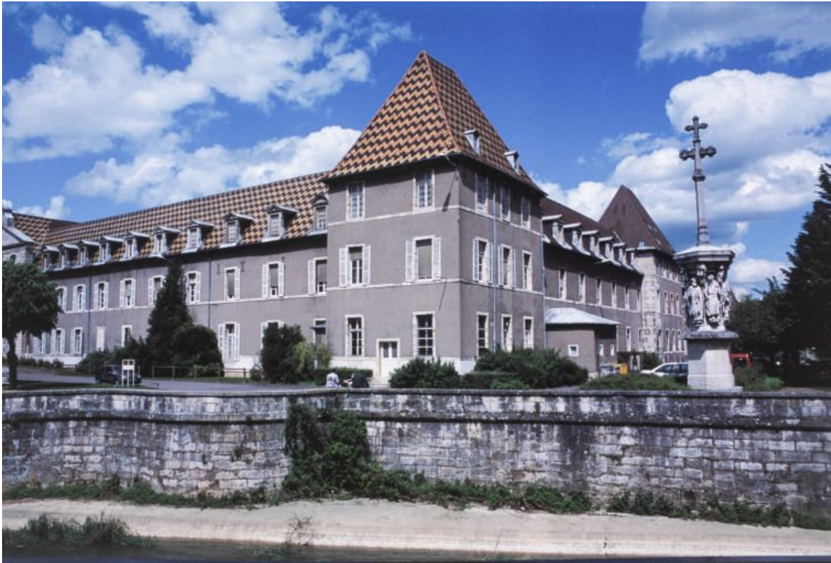
Vue prise du sud-ouest.
