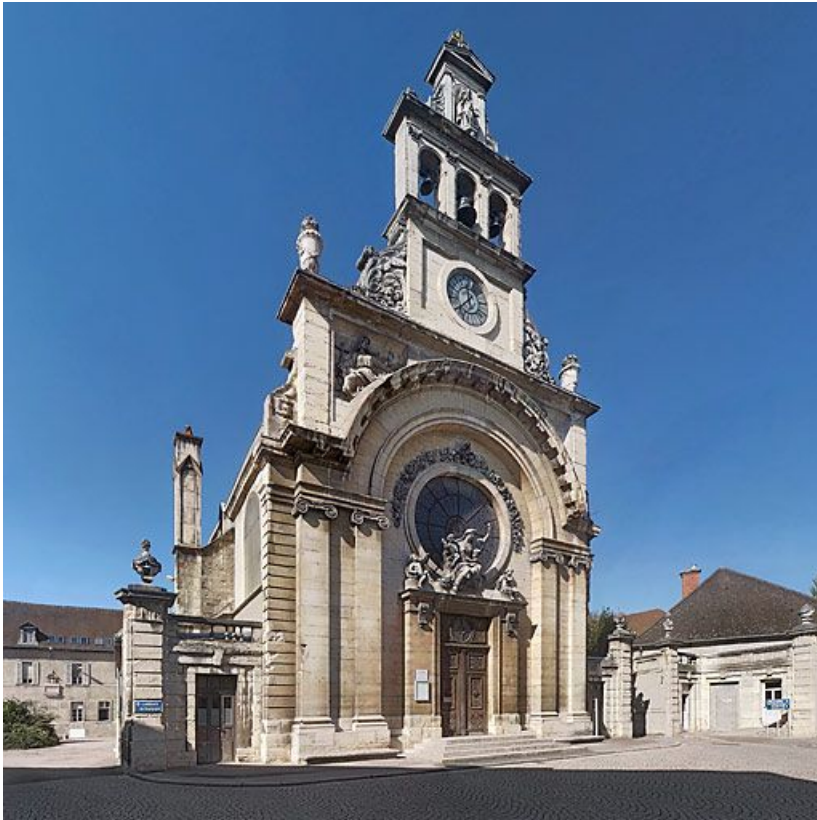
Façade de la chapelle.
