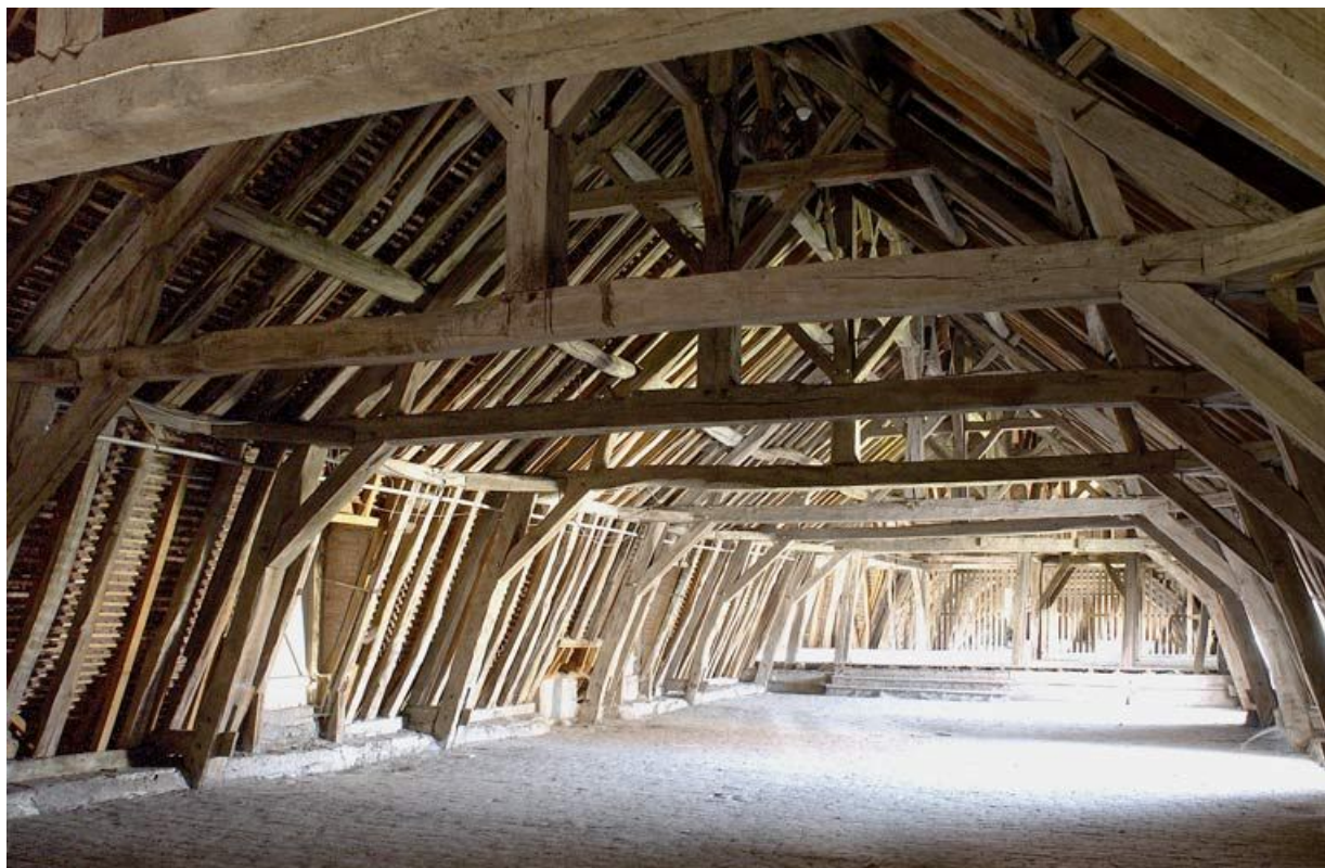
Aile droite : charpente.
