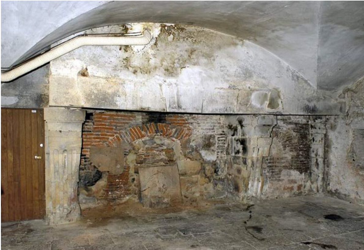
Ancien hôtel du gouverneur : sous-sol, cheminée.
