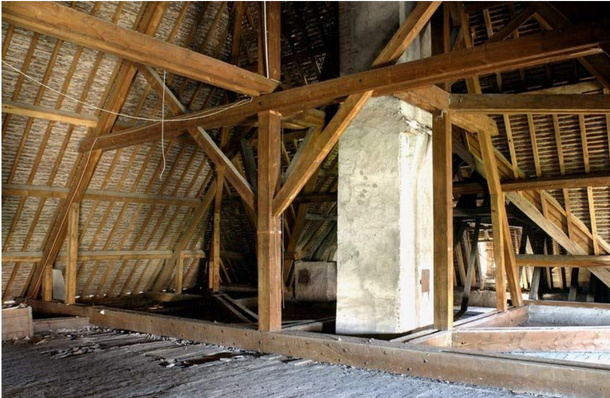
Aile droite : charpente.
