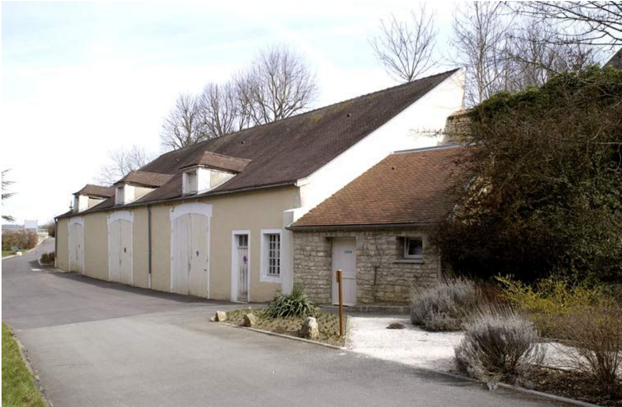
Bâtiment dit les Granges.
