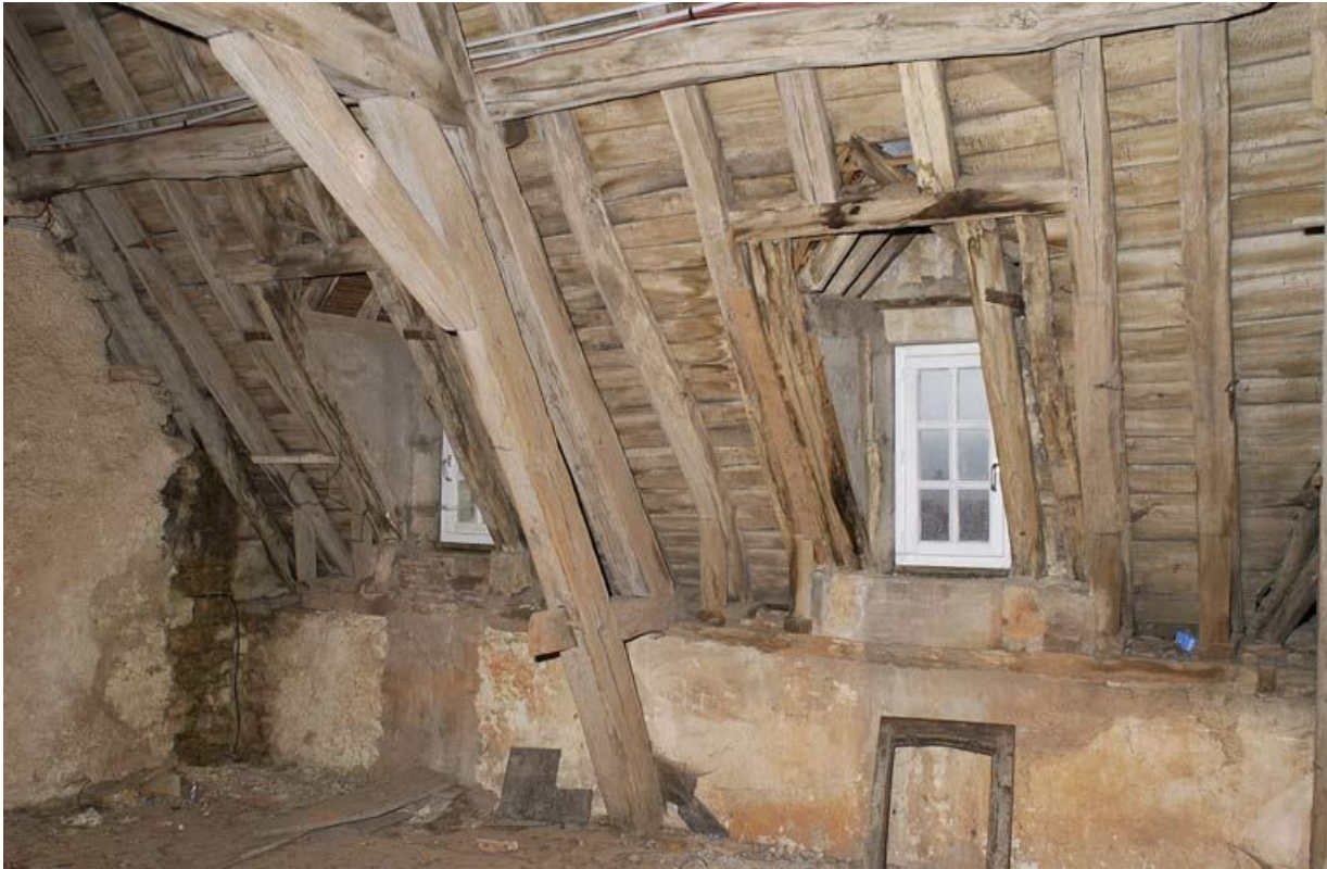
Corps de bâtiment principal : charpente au-dessus de la salle Sainte-Cécile (versant antérieur). 21, Alise-Sainte-Reine Bains
