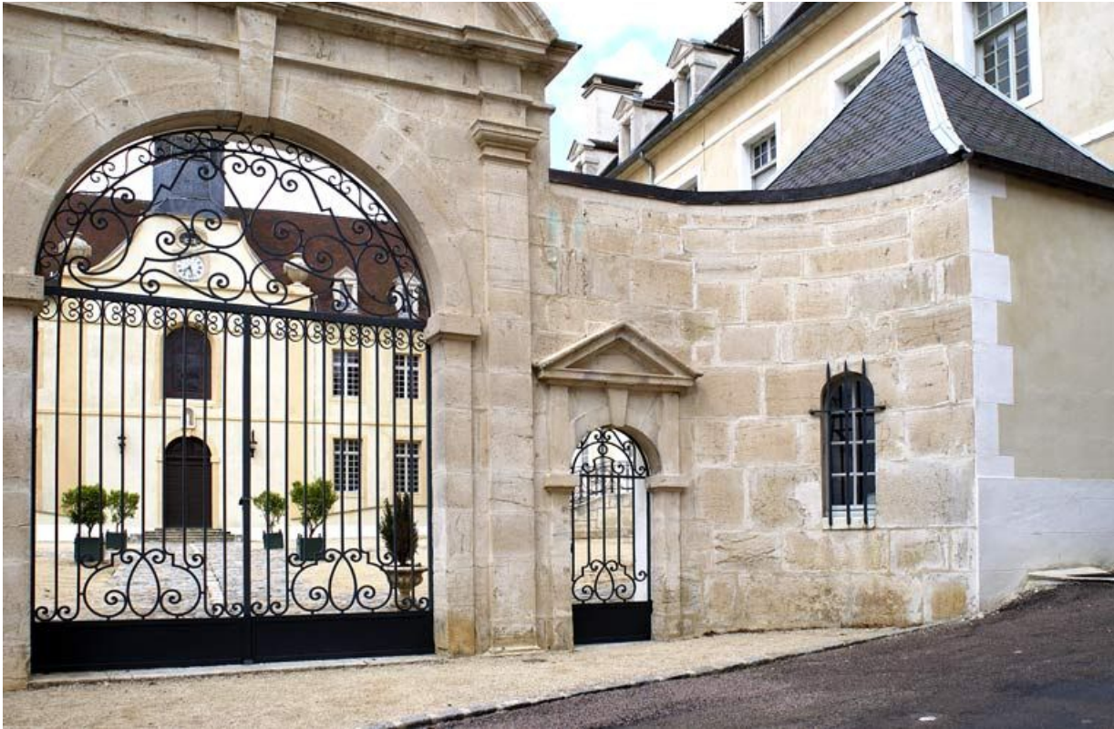
Portail et porte piétonne.
