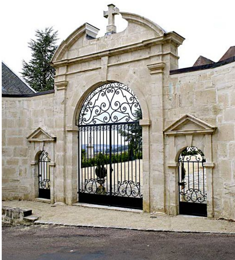
Portail à portes cochère et portes piétonnes.
