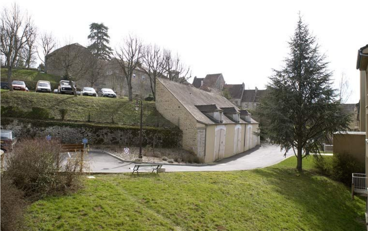
Bâtiment dit les Granges.
