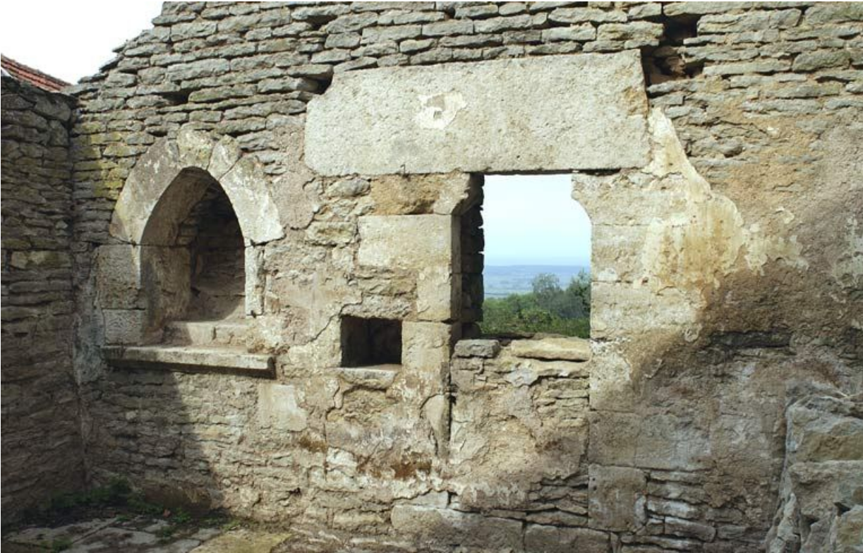
Chapelle, mur ouest, en 2002.
