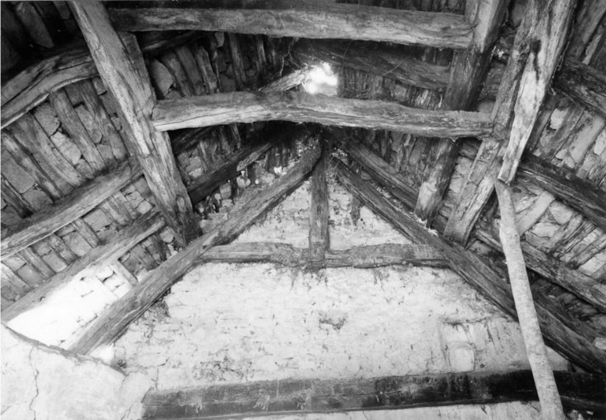
Charpente de la chapelle en 1975.
