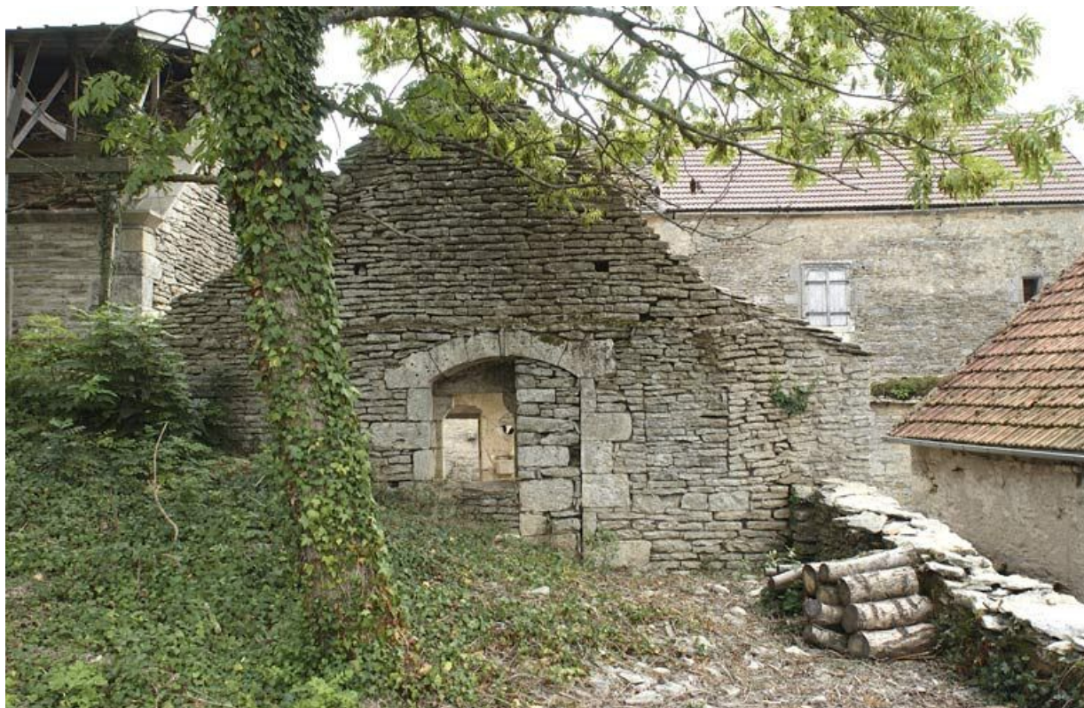
Chapelle, élévation ouest, en 2002.
