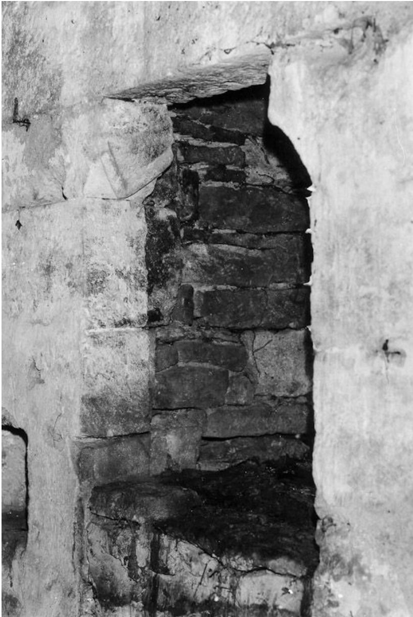
Chapelle, porte du mur ouest, en 1975.
