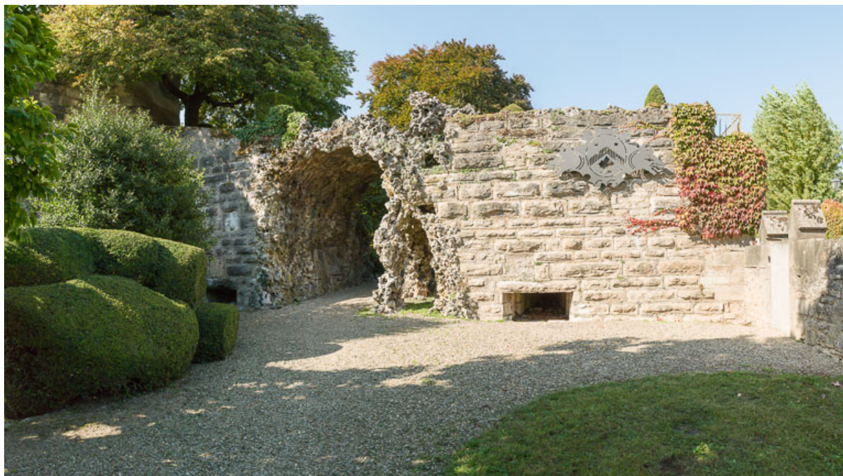
Passage aménagé dans l'ancienne courtine.
