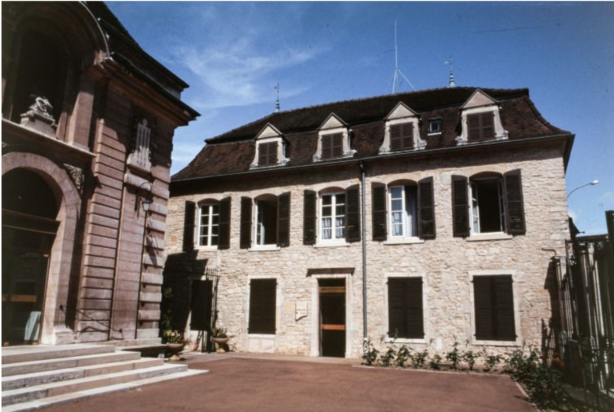
Bâtiment dit de l'administration : élévation antérieure.
