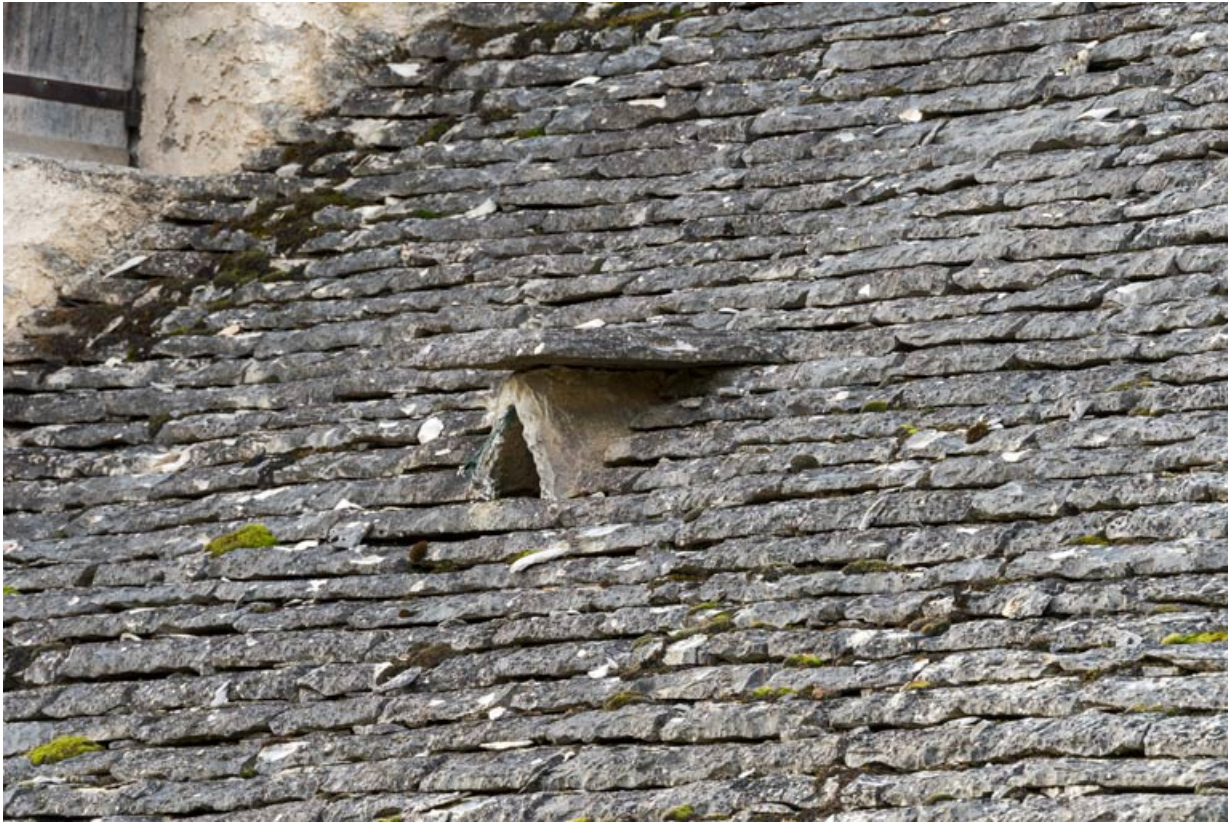
Détail de la toiture côté nord.
