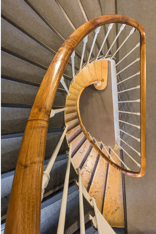
Escalier côté cour : rampe vue du dessus.
