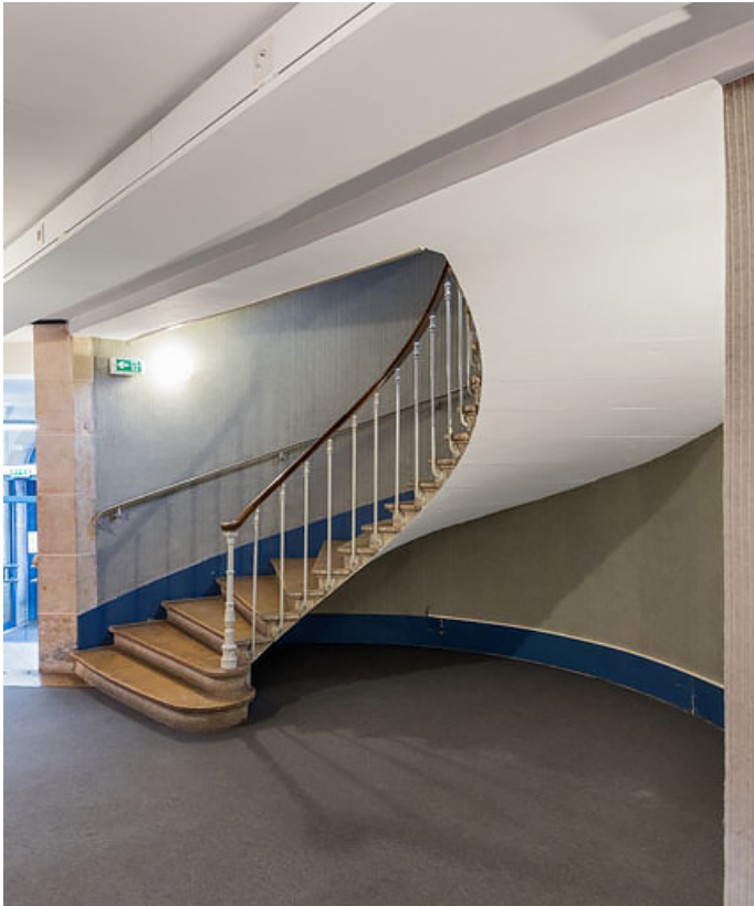
Escalier côté jardin : départ au rez-de-chaussée.
