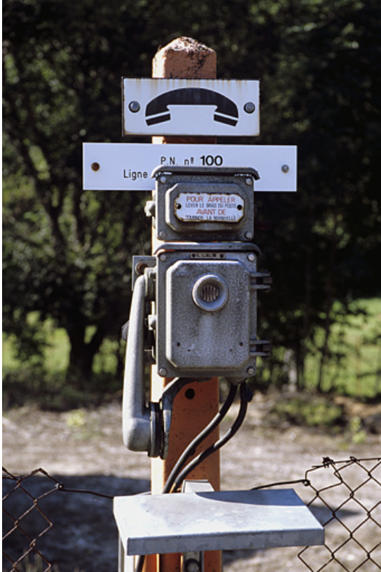
Téléphone de voie du passage à niveau n° 100.
