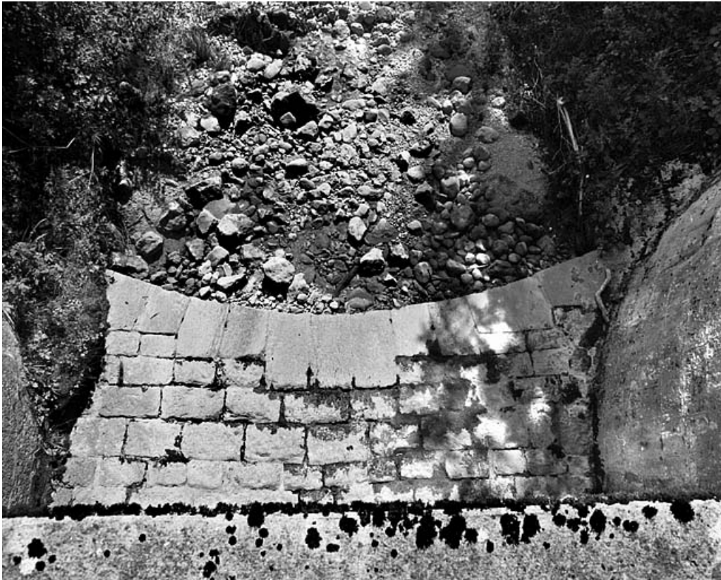
Pont : vue plongeante sur le radier aval.
