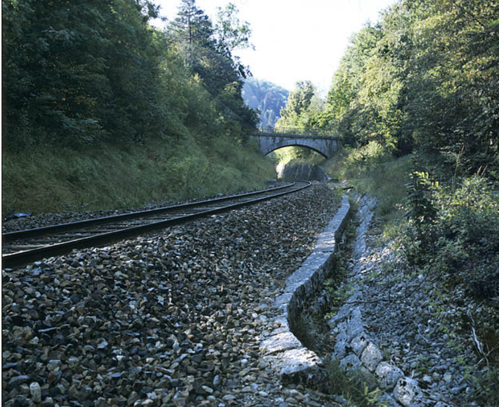
Vue d'ensemble, depuis le côté Andelot-en-Montagne (nord).
