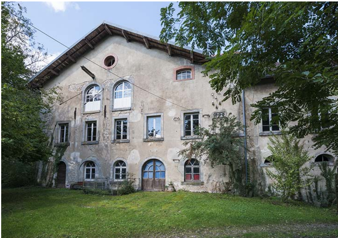
Façade antérieure de l'atelier de fabrication.
