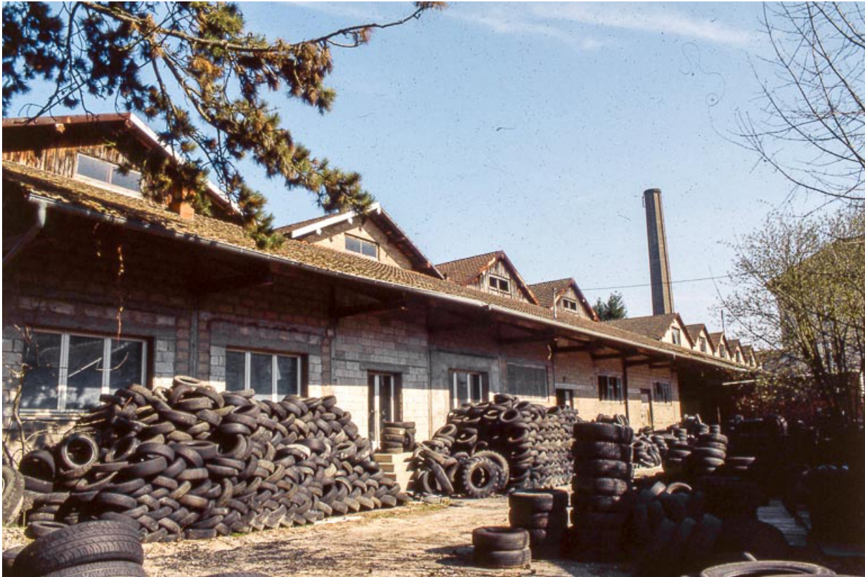
Quai couvert et magasins industriels depuis l'ouest.
