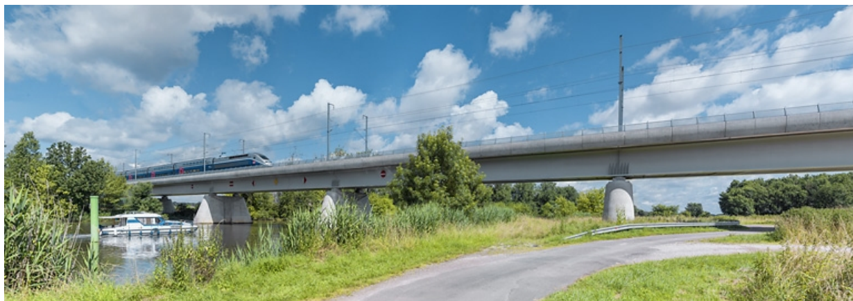
Vue d'ensemble avec TGV franchissant la Saône.
