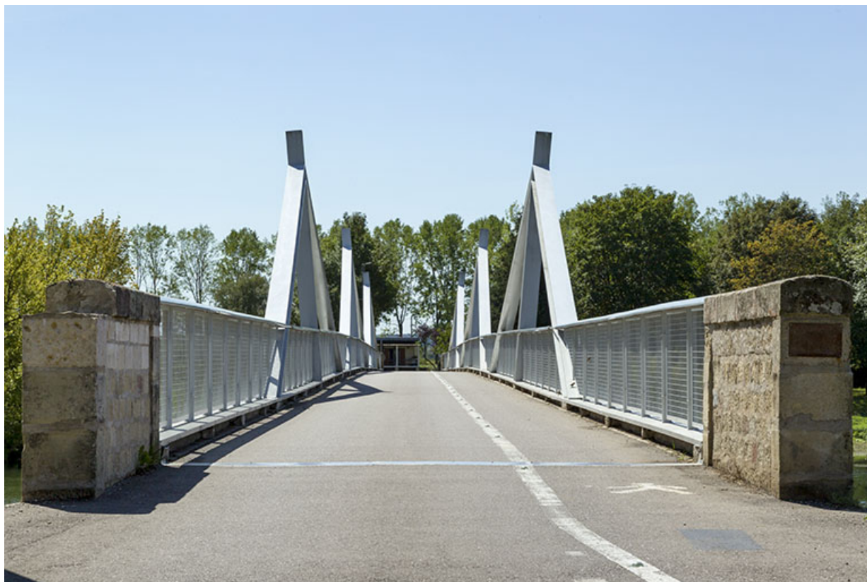
Pont de Rigny.
