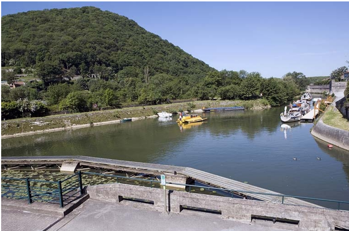
Bassin, depuis la route à l'est.
