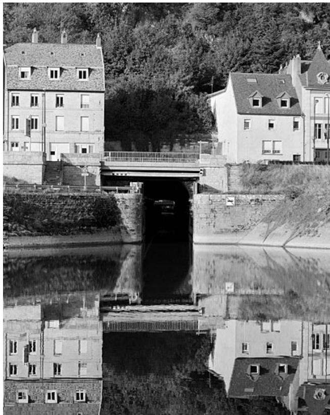
Porte de garde et extrémité amont.
