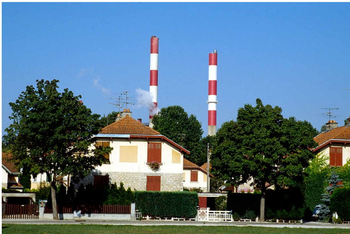
Maison d'ouvriers de type 10A, 10, 12 rue Carnot.
