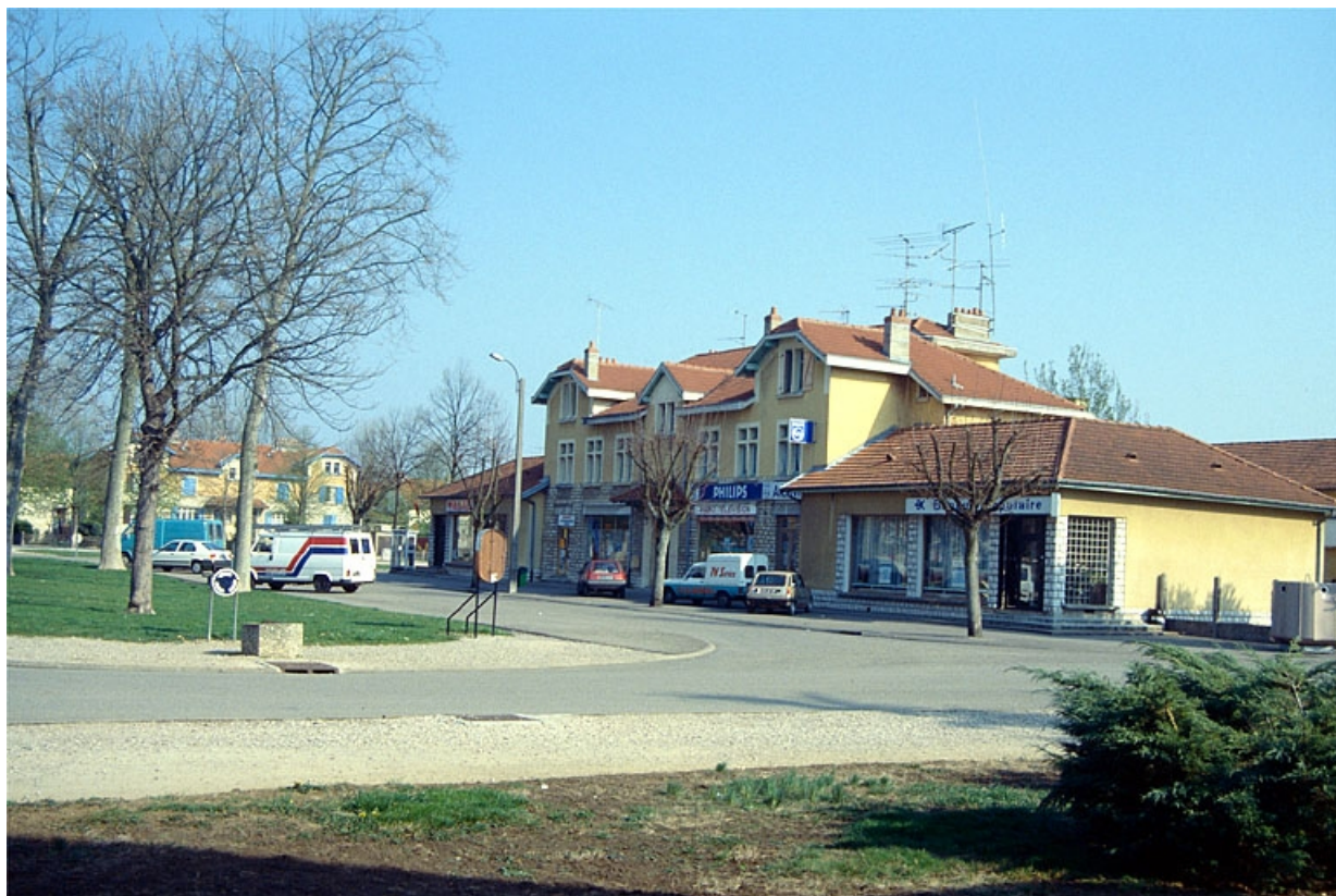
Immeuble avec boutiques, 2 place de la Victoire.
