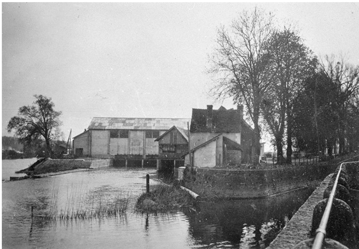
Station et moulin. Côté canal d'amenée.
