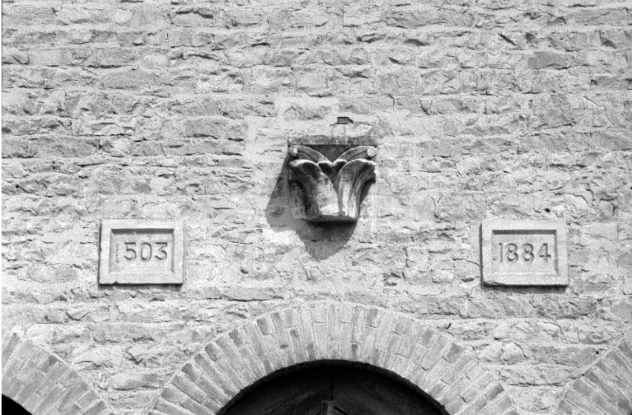
Atelier de fabrication : chapiteau et dates portées.
