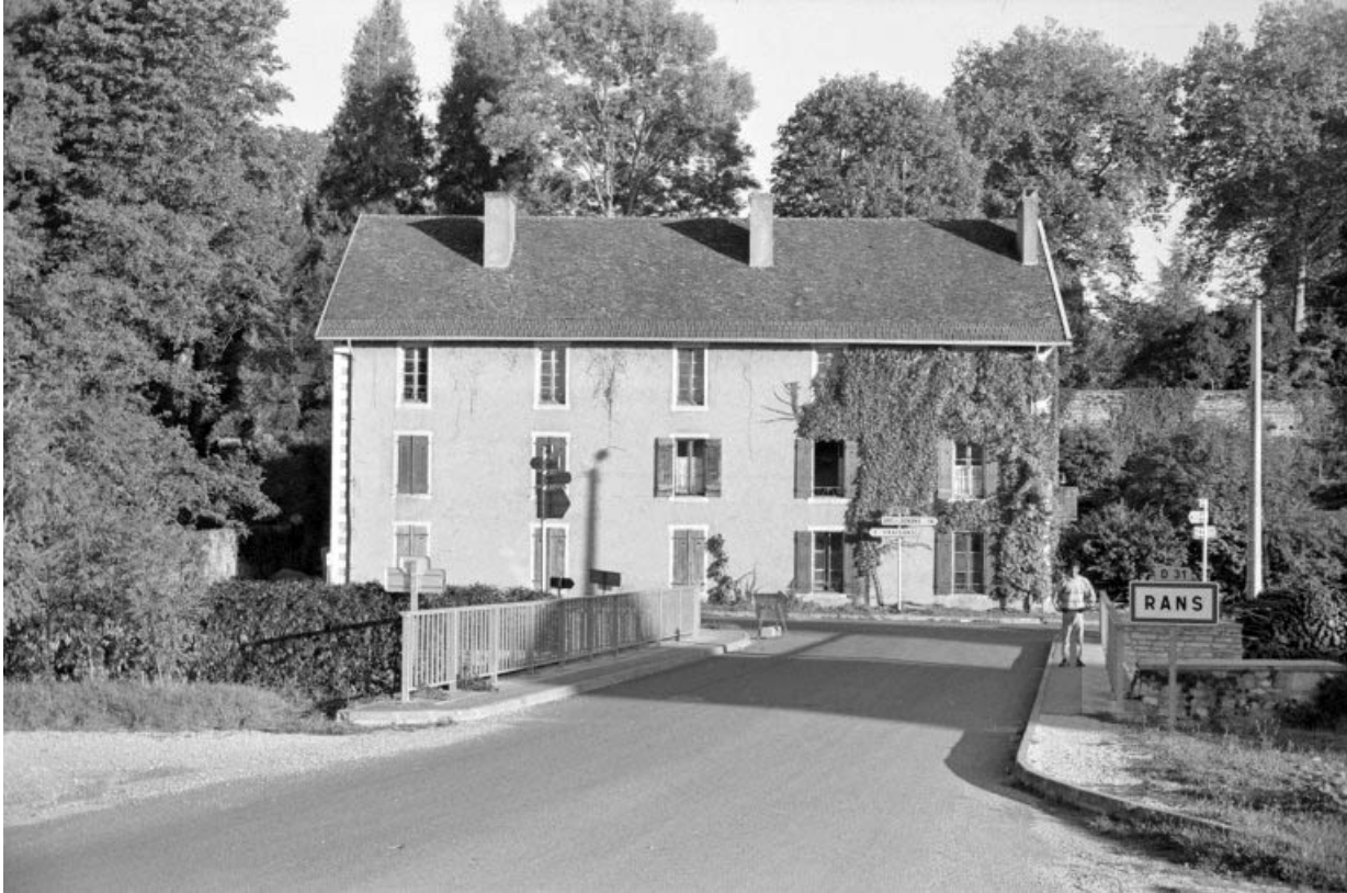
Façade antérieure du logement d'ouvriers (J).
