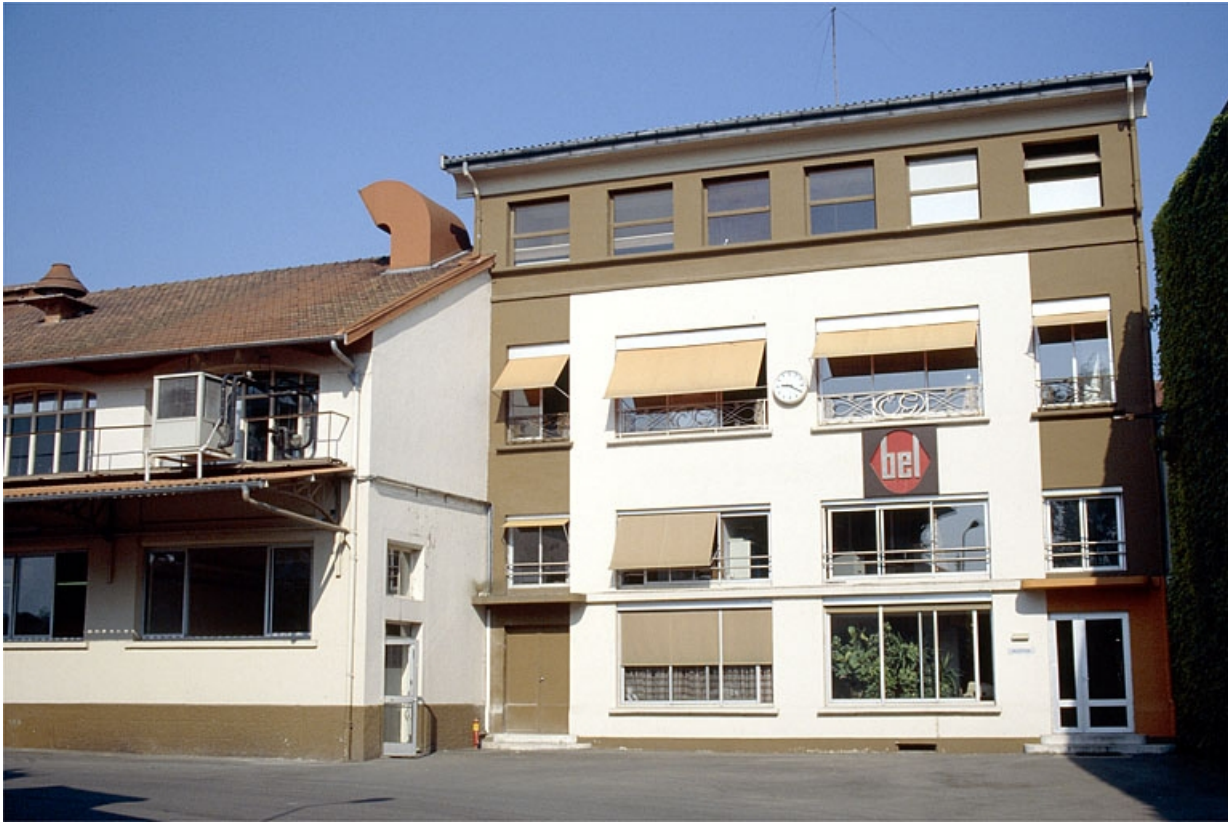
Façade antérieure des bureaux.
