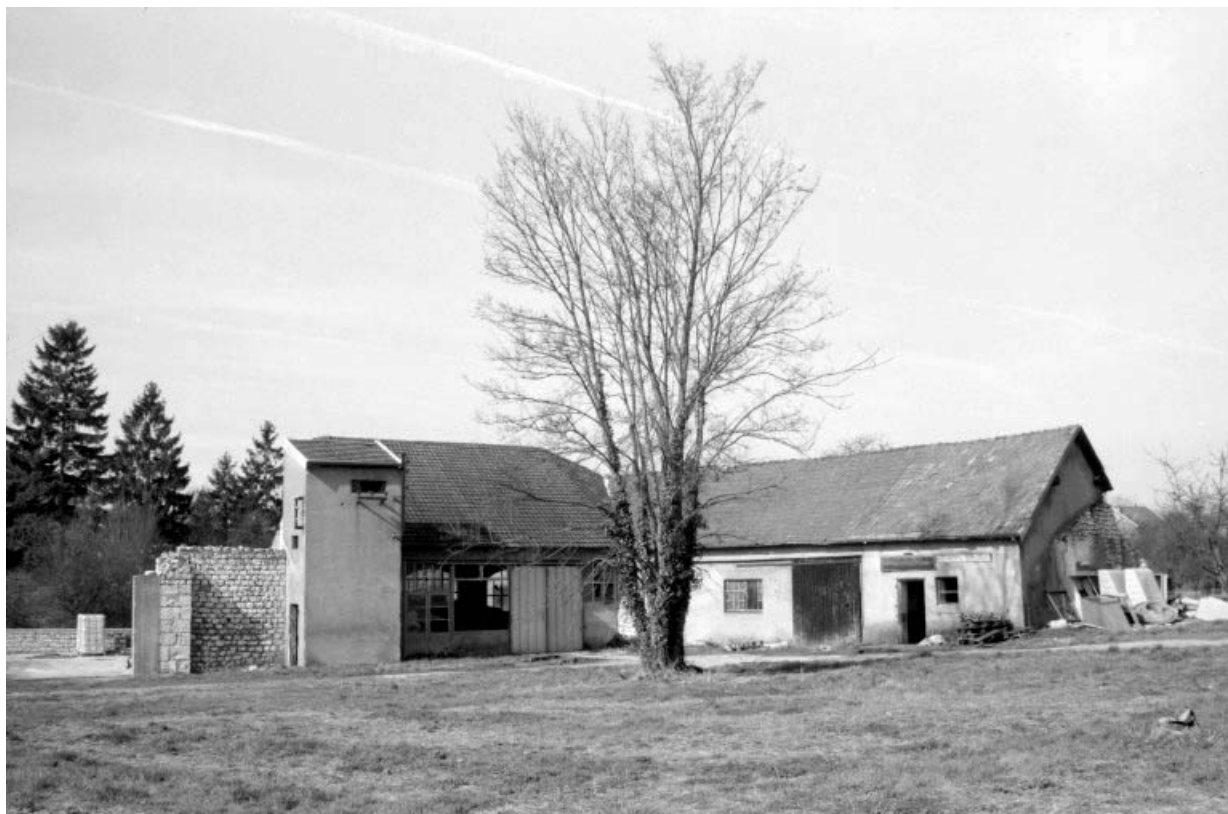
Fabrique d'aliment pour bétail : écuries et transformateur.
