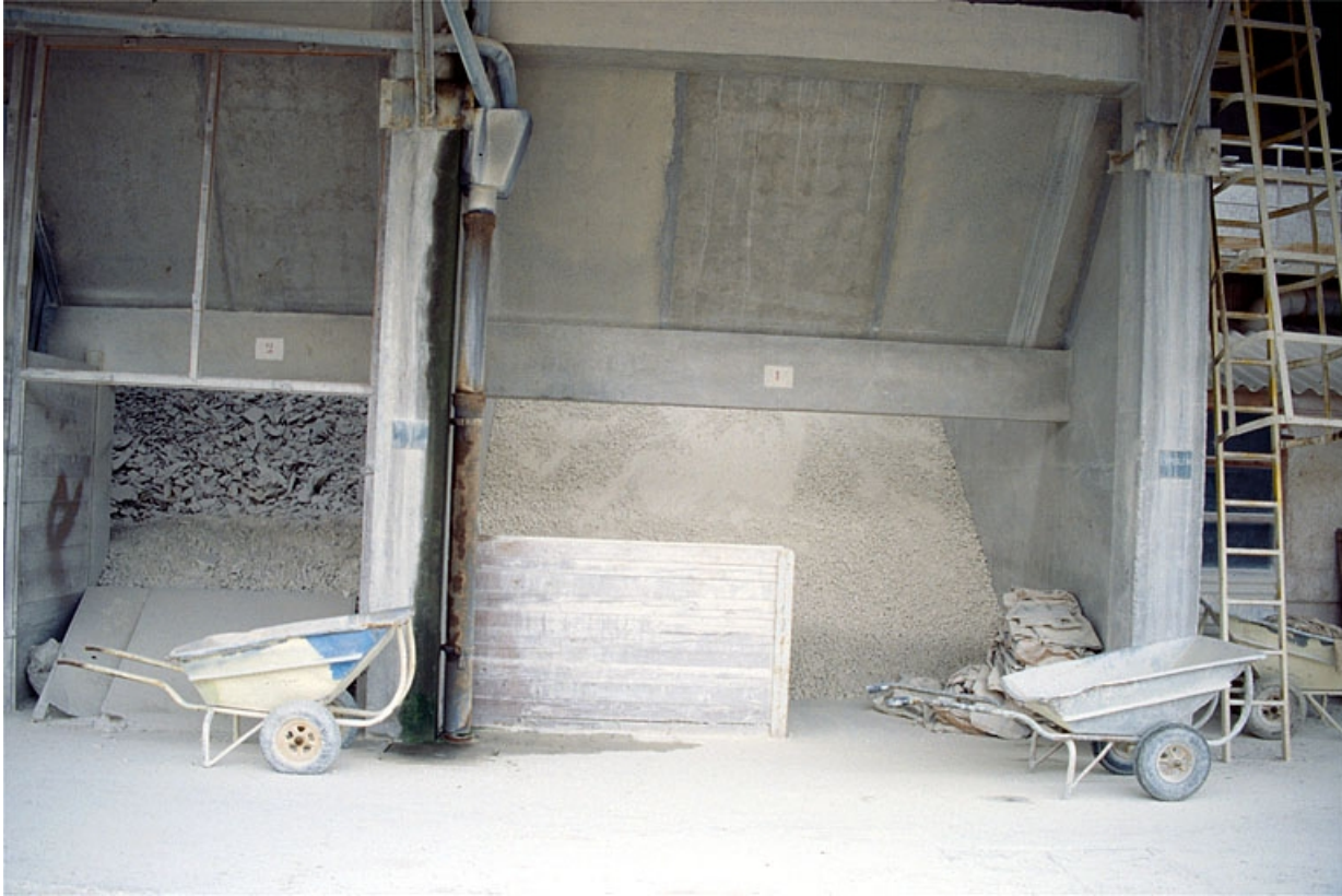
Hangar à terre (18) : détail des silos ouverts.
