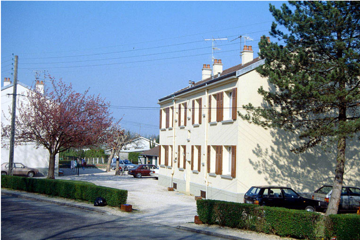
Immeuble semblable, 32 rue des Verneaux.
