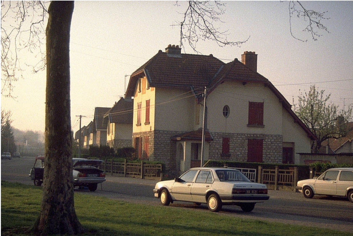
Façade antérieure et face latérale droite.
