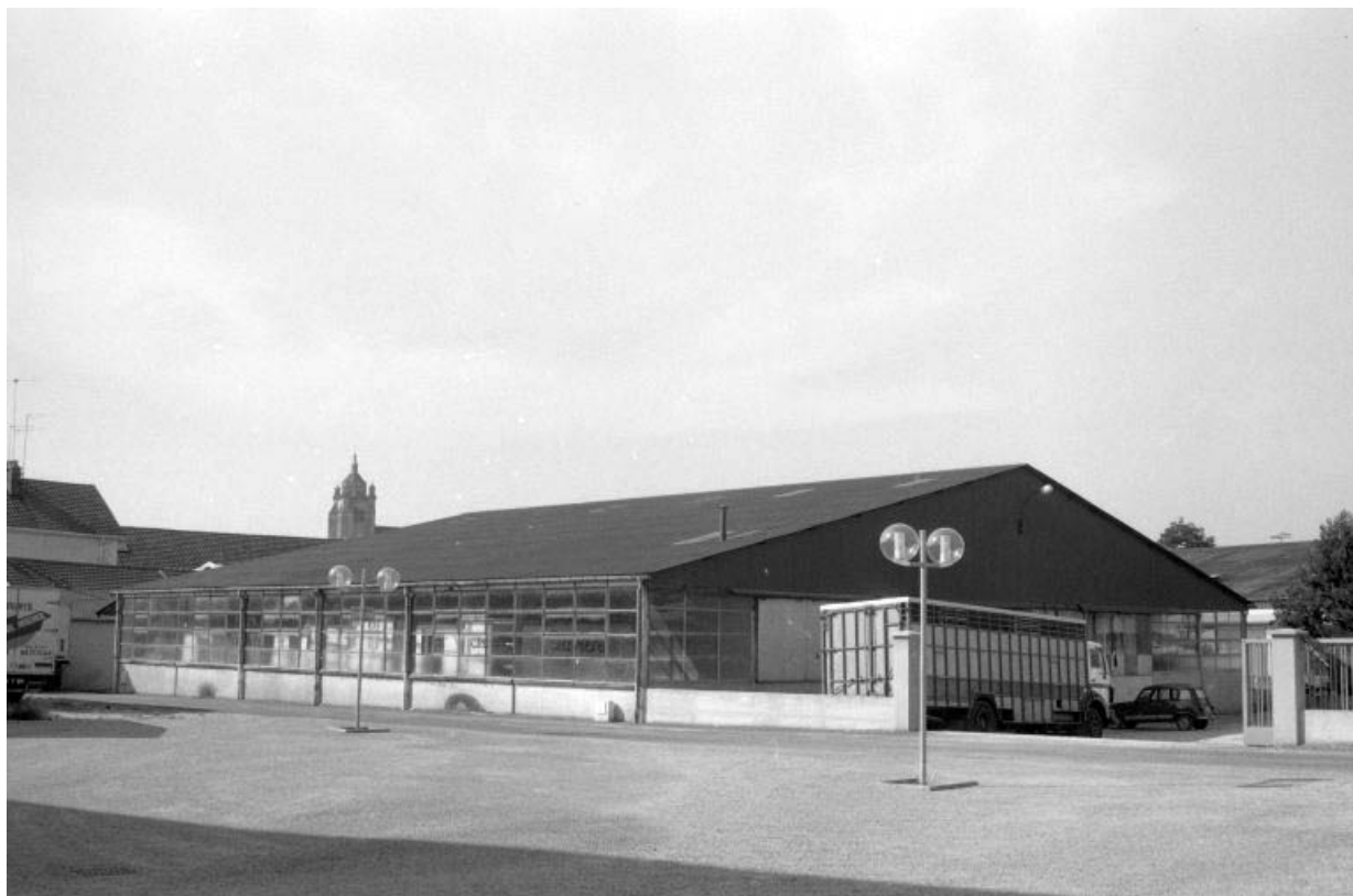
Remise (ancienne usine U.M.D.).
