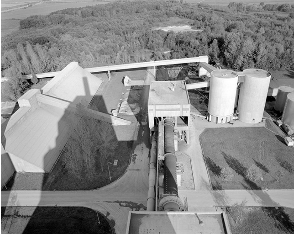
Stockage clinkers (D) et four rotatif, depuis le haut des silos.
